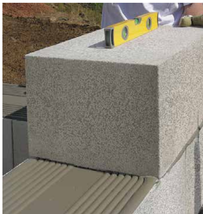
Процесс укладки блоков
